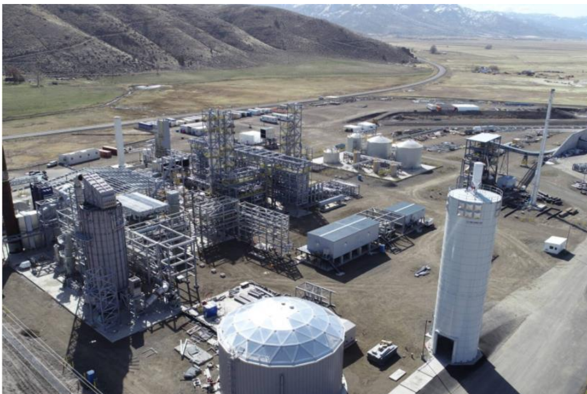
Figur 25. Figuren visar bioraffinaderiet RedRock Biofuels i Oregon, USA som är under uppförande. Processen är förgasning av skogsrester, grot, följt av FT med uppgradering till biodrivmedel. Källa https://www.redrockbio.com/ .
