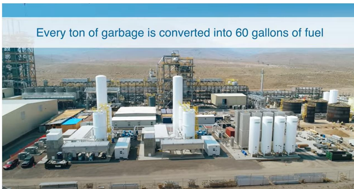
Figur 26. Figuren visar en drivmedelsanläggning som byggs av Fulcrum i Nevada, USA. Processen är förgasning av hushållsavfall (MSW) följt av FT med uppgradering till drivmedel. Källa https://fulcrum-bioenergy.com/ .
